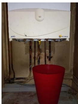
Changement du vase d'expansion et entretien annuel de notre chaudière
